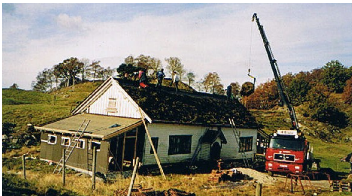
Åsenhuset under restaureringsarbeidet
