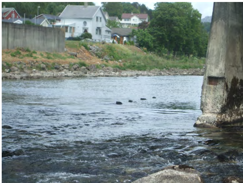
Her ser vi rester etter fire pilarer av brua. Alle er tydeligvis kappet av rett over vannflaten ved liten vannstand i elva.
