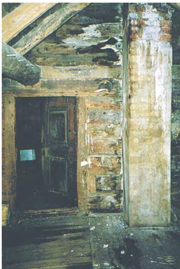
Pipa gikk opp gjennom den midterste sovesalen. Pipa var satt opp på 1930-tallet, og var murt opp av murstein. Den opprinnelige gråsteins-murte pipa var det fremdeles godt synlige merker etter på denne tømmerveggen. Slik kunne en se hvor den hadde stått og likeledes dens størrelse.
