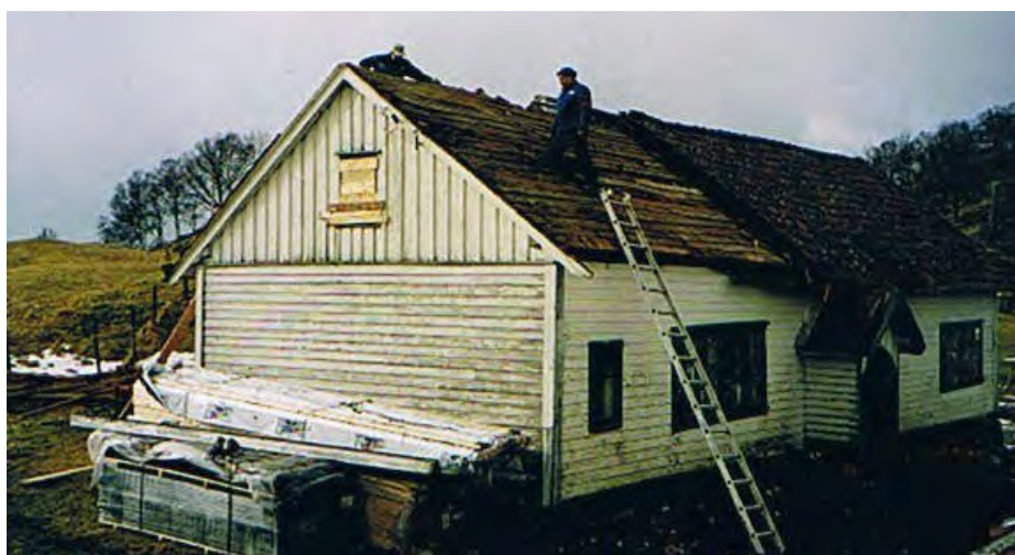
Under taksteinen ligger det opprinnelige torvtaket intakt.
