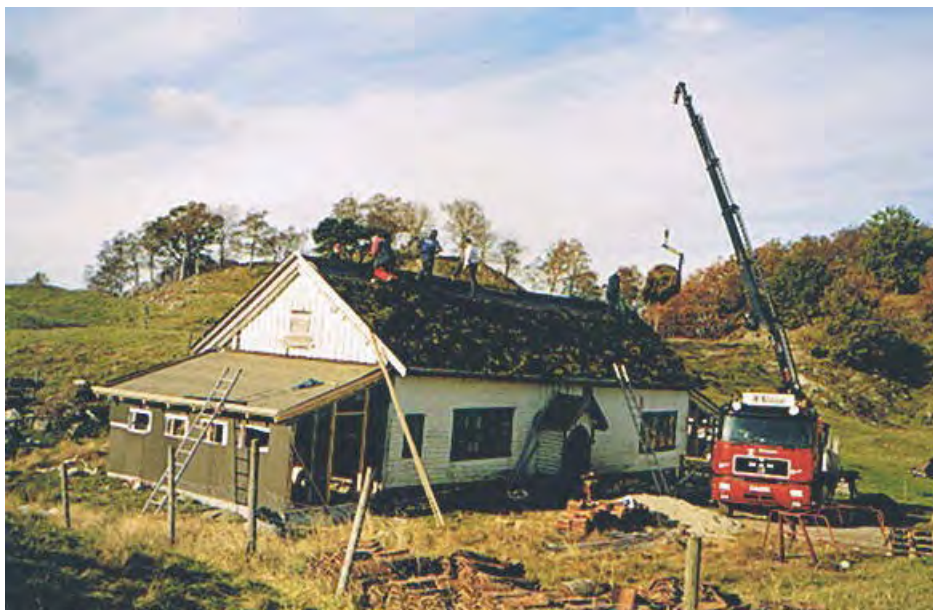
Restaureringsarbeidet utvendig går mot slutten. Deretter gjenstår innvendig arbeid, samt skutene i begge ender av huset.
