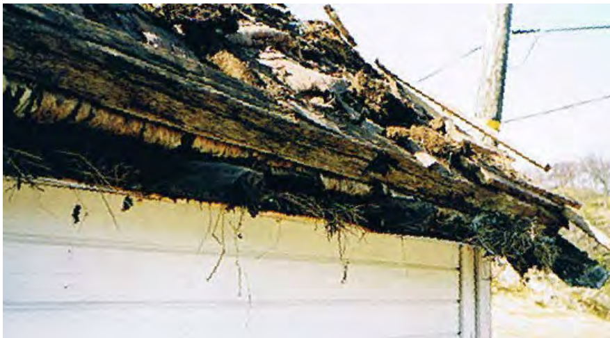
Her ser vi noe av det opprinnelige torvtaket. Dette ligger helt intakt med taktribord, bjørkenever i flere lag, torvresten og nederst torvstokken som holder det hele på plass.
