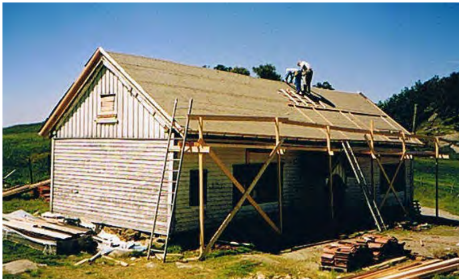
Det legges helt nytt sutak oppå de nye takbjelkene, og med takpapp ovenpå..
