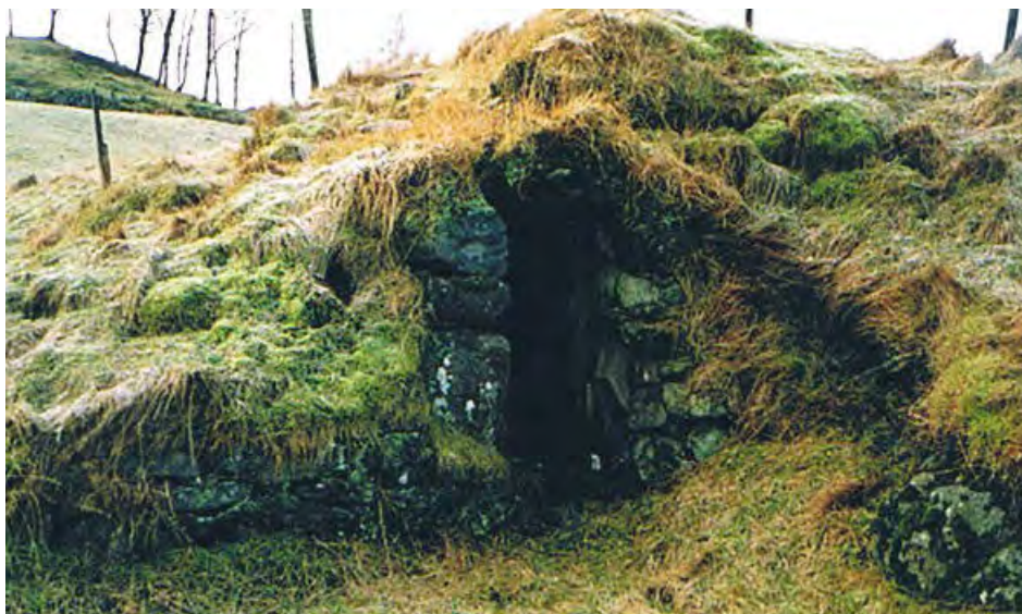
Potetkjelleren bak huset. Alt innvendig er steinsatt, også taket.
