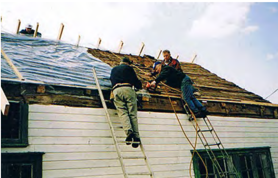
All never ble tatt ned og vasket. Deretter lagt tilbake på taket, godt synlig fra takets innside, i mellom taktribordene, slik neveren alltid hadde ligget.
