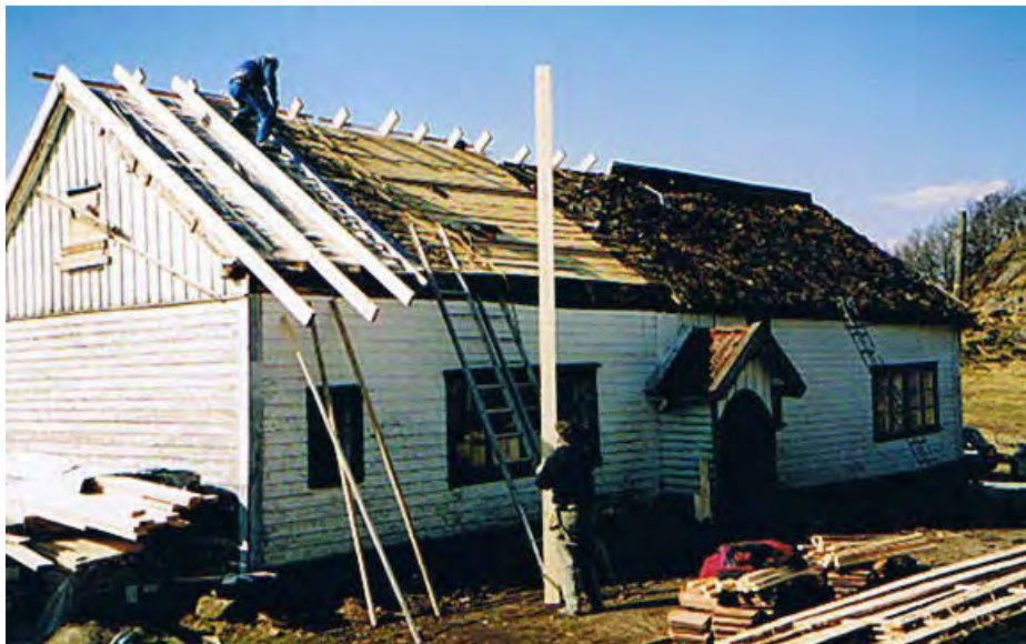
Når torvtaket var fjernet, vart det lagt opp nye takbjelker oppå de opprinnelige taktrobordene.
