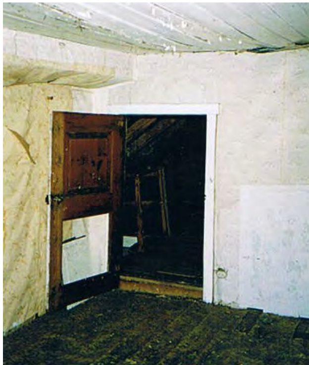
Sovesalen ovenfor bestastova. Denne salen var innredet med et skråkammer på hver side, og avpanelt i taket. Alle veggene var kledd med fiberplater og papp. Døra var av gammel type, og var sannsynligvis fra 1740 da huset ble forlenget med bestastova nede og denne salen oppe.
