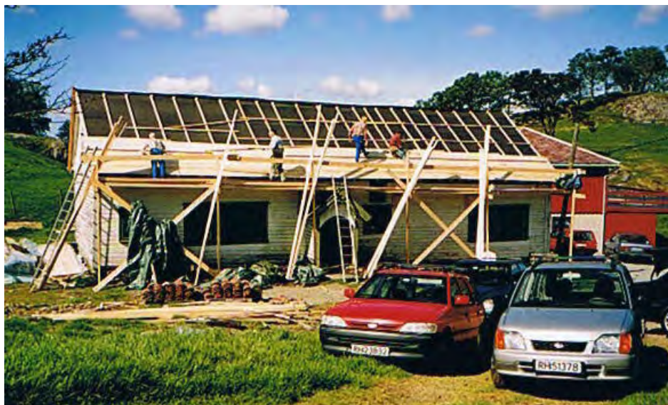
Takutstikket ble løftet opp, slik at det det ikke skal sees at det nye taket har langt større tykkelse enn tidligere. Taket er innvendig som før, og er isolert, og forsterket med nye ikke synlige takbjelker.
