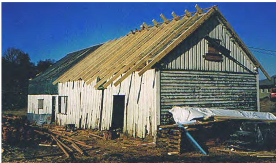
Taket vart således forsterket for det nye torvtak som skulle komme oppå.
