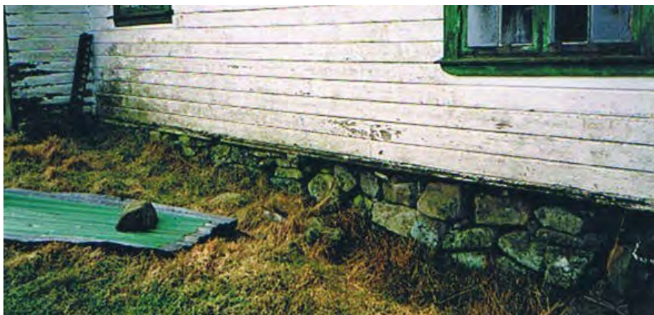
Kjellermuren på fremsiden. Brønnen ligger under bølgeblikkplata.
