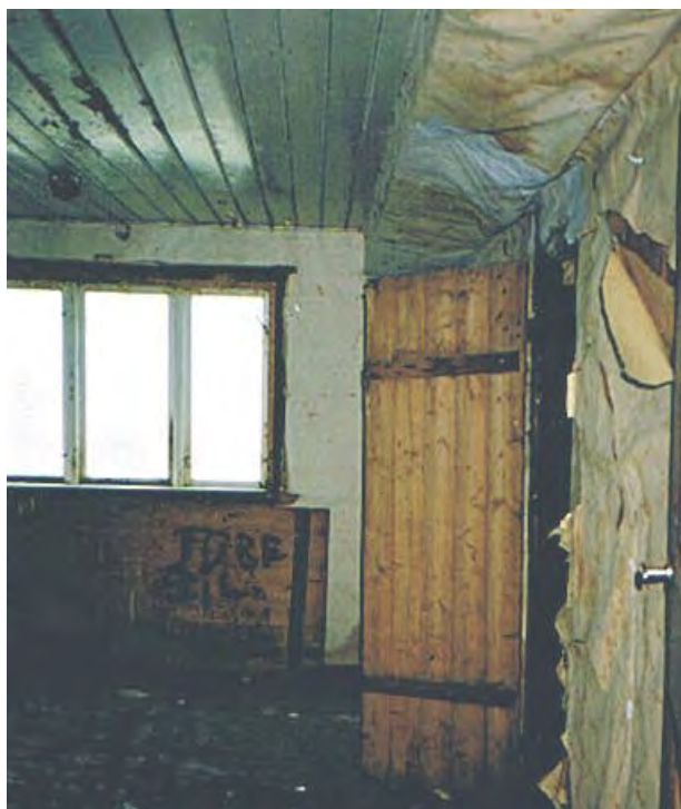
Her ser vi samme sovesalen, med dør til skråkammeret og vinduet. Dette vinduet var av nyere dato. Tilfeldigvis fant vi det gamle vinduet med sprosser vel bevart i det ene skråkammeret. Vinduet var i god stand og var sannsynligvis fra 1740 da salen var ny. Vinduet utmerker seg med fine utskjæringer på alle sprosser.
