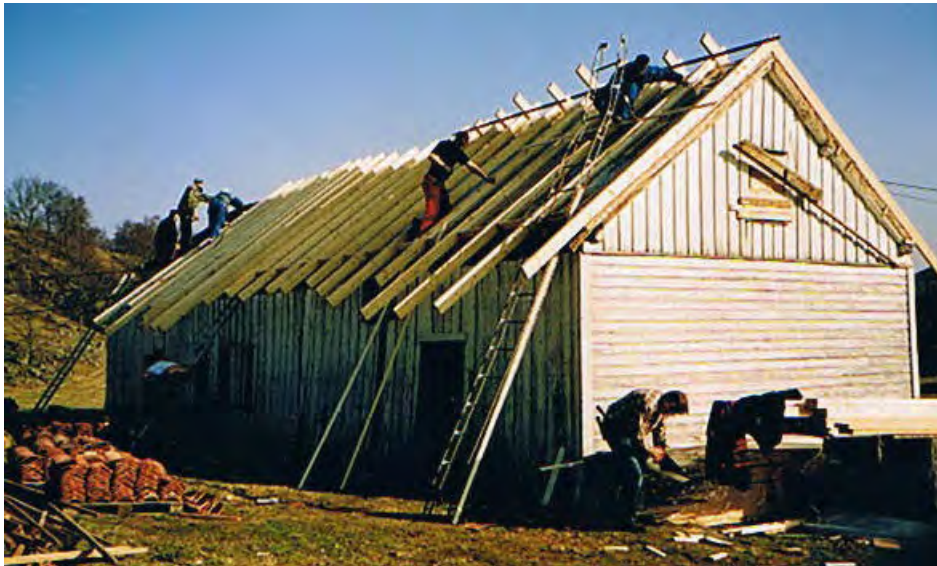
Mellomrommet mellom takbjelkene ble fylt i med isolasjons-matter, og rom for lufting..
